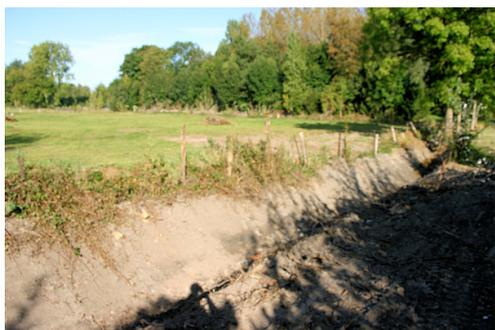
Curage du fossé ( 430m) de la rue d'en Bas jusqu'à la rue du jeu de Paume pour faciliter l'écoulement des eaux en cas de forte pluie. – travaux réalisés par l'entreprise DELAPORTE.
